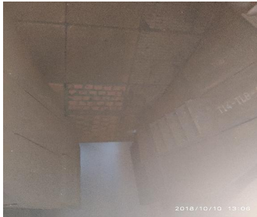
图 2 国内某输煤系统现场工况
