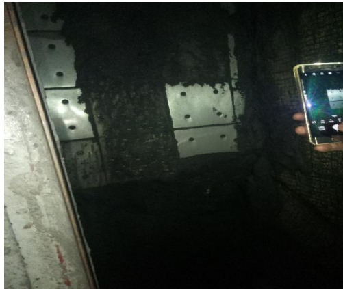
图 2 国内某转运系统落料管内部衬板
